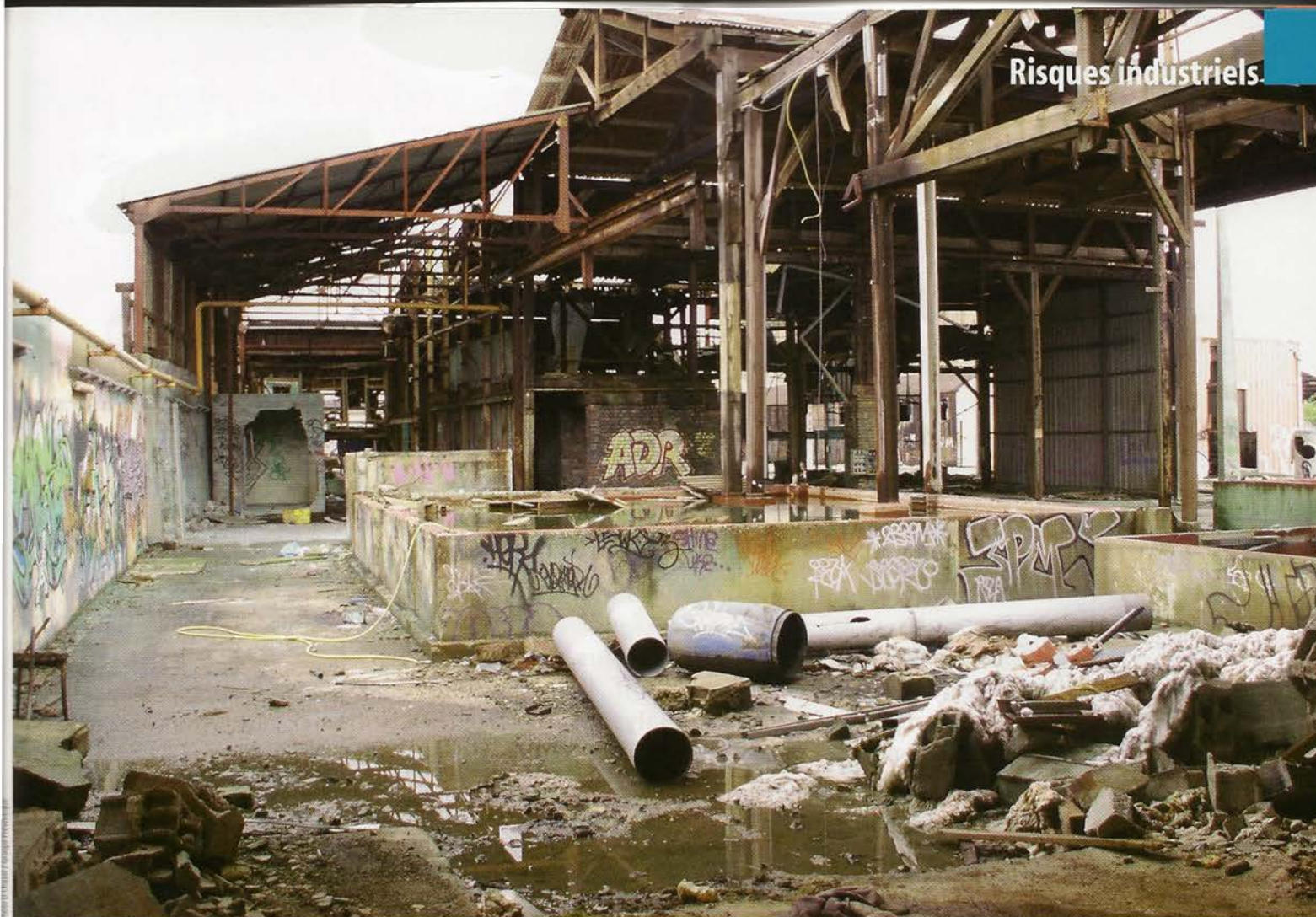
Un site industriel abandonné sans dépollution, l'ancienne usine La Cornubia à Bordeaux (ici en octobre 2008), en dépit de l'action des riverains.
